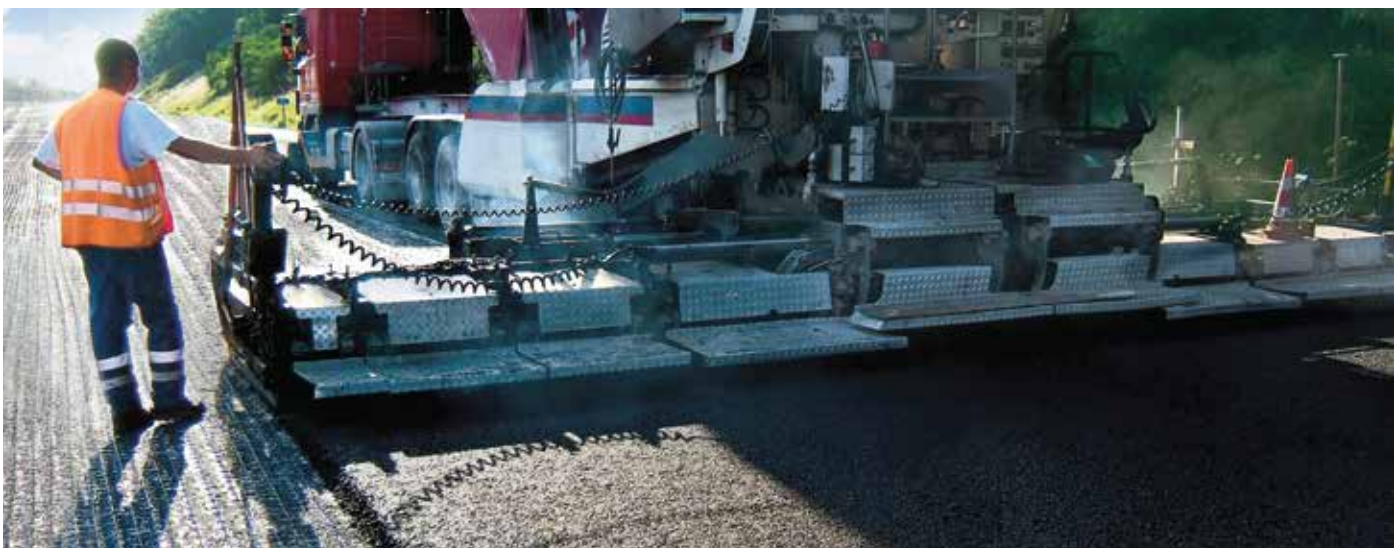
Trải thảm mặt đường trực tiếp trên lớp lưới Tensar AR-GN.
