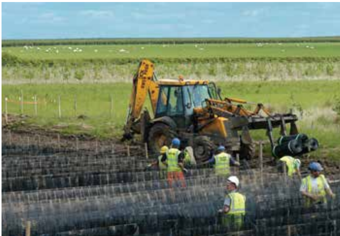
Kết cấu TensarTech® Stratum được sử dụng để kiểm soát độ lún lệch với điều kiện nền đất yếu và thay đổi.
