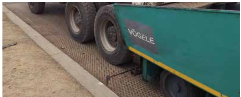
Mặt đường được gia cố bởi lưới địa kỹ thuật Tensar TriAx có thể giảm thiểu tình trạng xuống cấp của kết cấu và bảo vệ toàn bộ kết cấu mặt đường.
