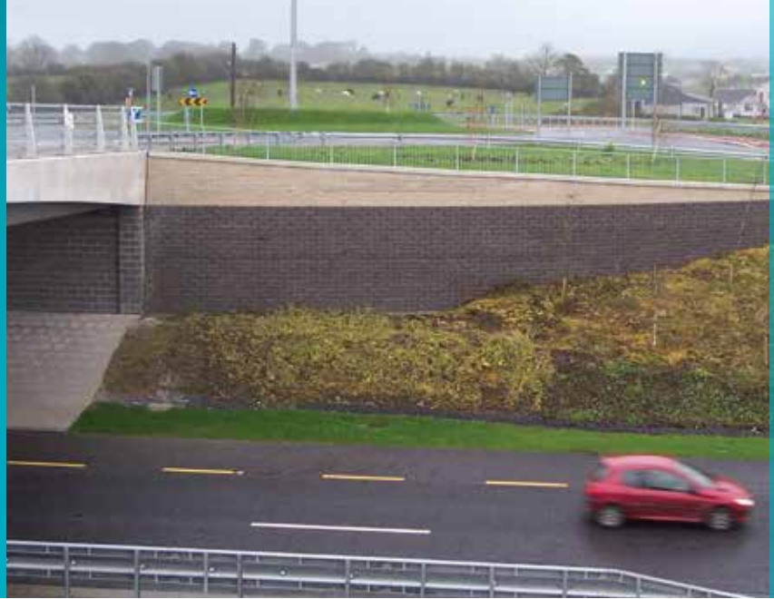
Kết cấu tường TensarTech – kết hợp khối phủ bề mặt hoàn thiện được sử dụng có tác động đáng kể tại vị trí tường cánh mố cầu.
