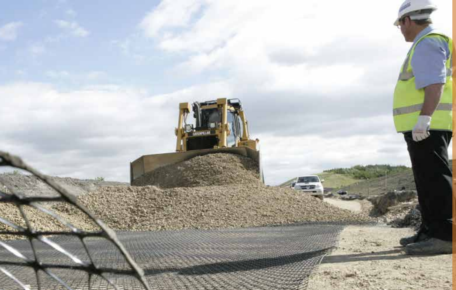
TriAx® cải thiện độ lèn chặt và liên kết của lớp cốt liệu, tăng hiệu suất làm việc của kết cấu lớp gia cố cơ học.
