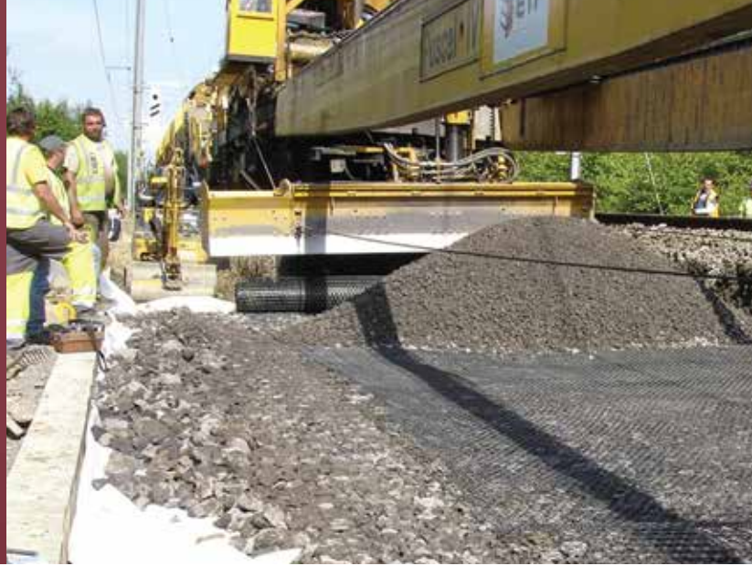
Lưới địa kỹ thuật Tensor® TriAx® được trải dưới lớp cốt liệu nền cho lớp ba-lát để tăng sức chịu tải (Bi).
