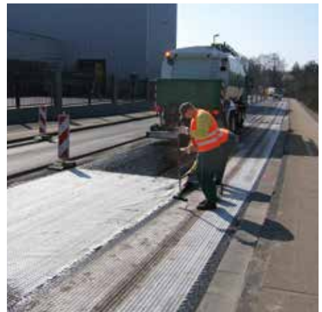
Khớp nối gối đầu đơn giản với Tensar Glasstex.
