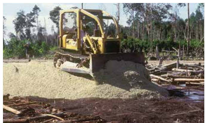
Thi công nền đường với LTP trên lớp bùn sét (Indonesia).
