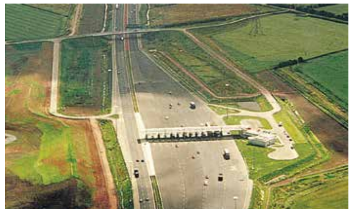
Trạm thu phí Second Severn được gia cố bởi lưới địa kỹ thuật Tensar LTP (Anh).
