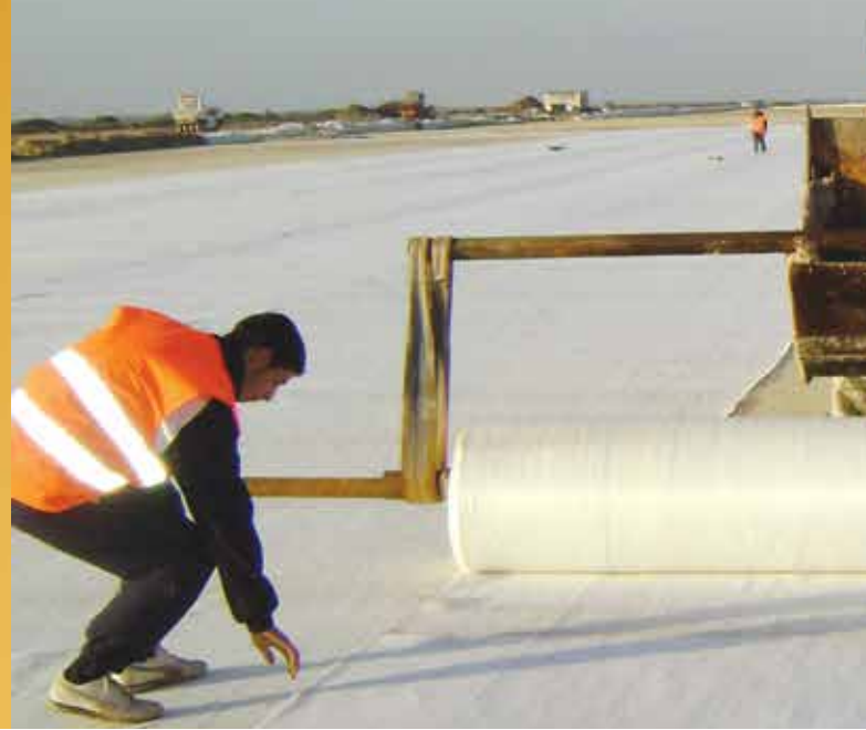
Lắp đặt Vải địa kỹ thuật Tensar® Basetex™ tại sân bay Oran ở Algeria mang lại hiệu quả về chi phí và cung cấp giải pháp gia cường vĩnh cửu bên dưới lớp đắp.
