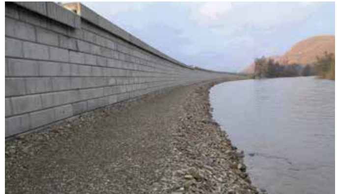
Kết cấu TensarTech Marine rất phù hợp với các điều kiện ven biển hoặc có thủy triều lớn như bến cảng và các địa điểm ven sông.
