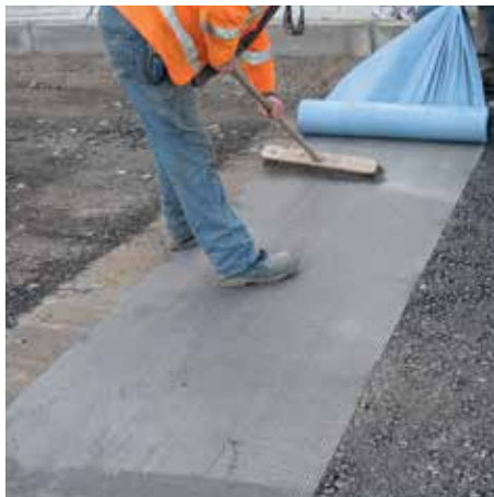
Glasstex@Patch™ 880 có thể được áp dụng cho hầu hết các bề mặt sử dụng lớp phủ dính.
