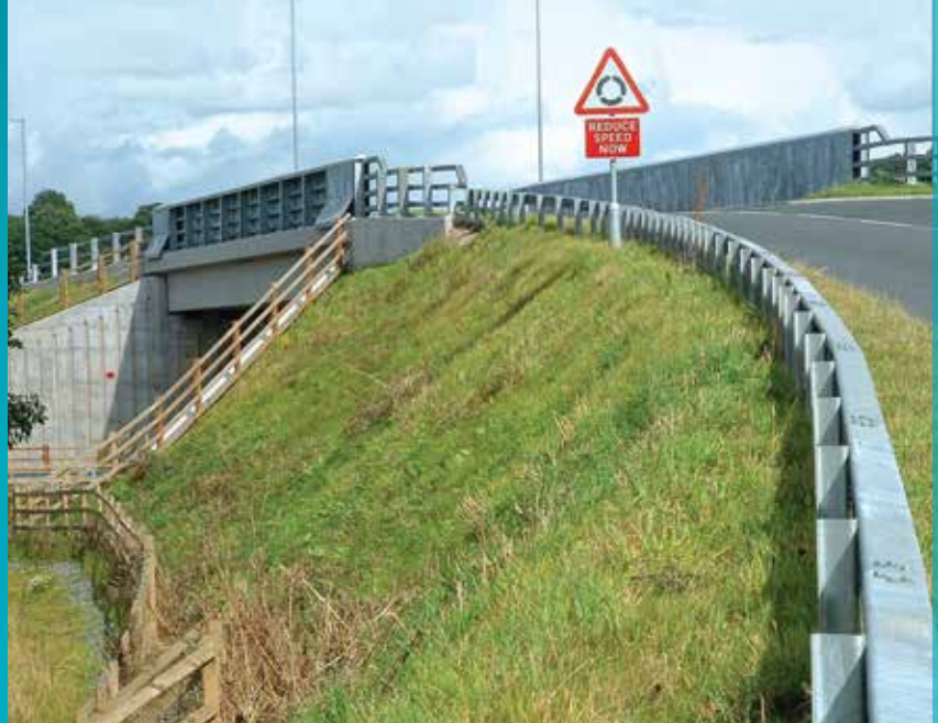
Kết cấu TensarTech cho mái dốc có thể rút ngắn thời gian thi công và giảm thiểu gián đoạn giao thông.
