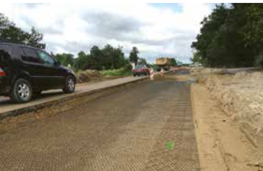
Obr. 5 Inštalácia šesťuholníkovej geomreže na ceste č. 507
